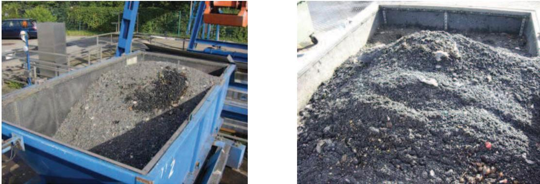
Abbildung 7.10: Aus dem Sedimentfang beförderte Ablagerungen nach der Stauwagenreinigung.
