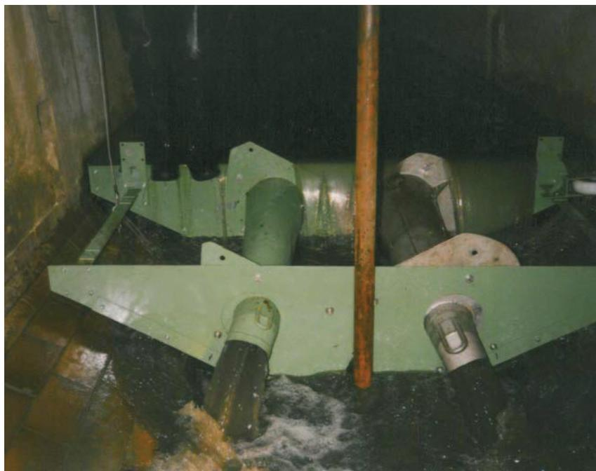
Abbildung 3.8: „Iltis“ für den Einsatz im Kastenprofil 2100/1650 mm (Foto: NVV AG Mönchengladbach).
