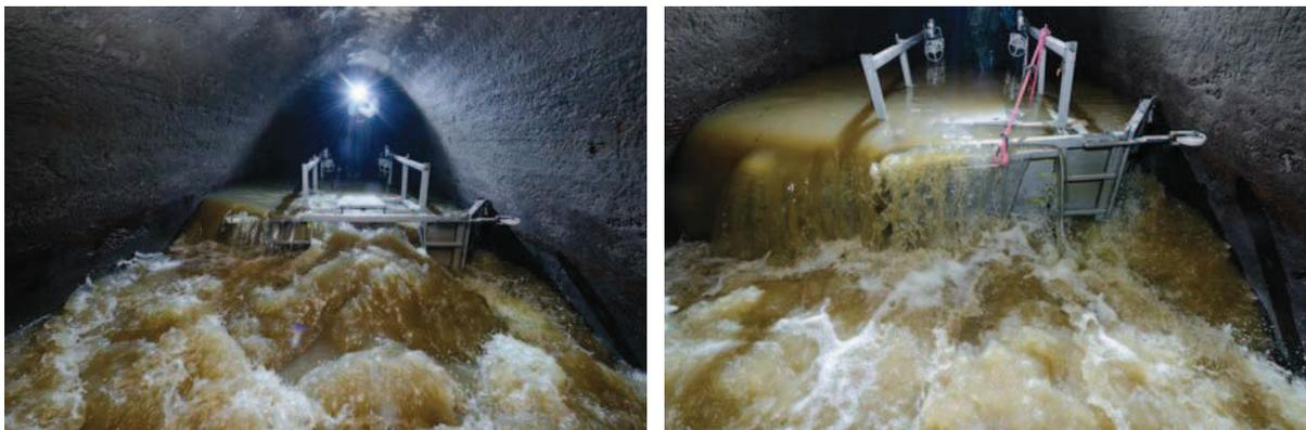
Abbildung 7.6: Stauwagen im Betrieb mit offener (links) und geschlossener (rechts) Entlastungsklappe während der ersten Testfahrt (Fotos: *wks Technik GmbH*). Die Klappe wurde im rechten Bild mit einer Kette fixiert, da zum Zeitpunkt der professionellen Aufnahme der Fotodokumentation Regenwetterabfluss herrschte und die Klappe somit automatisch öffnete.
