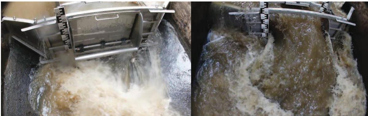
Abbildung 7.3: Reinigungsbetrieb mit geschlossener (links) und mit offener (rechts) Entlastungsklappe.
