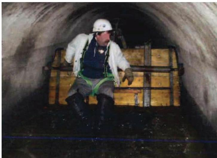
Abbildung 3.10: „Hunt“ für Maulprofil  $DN\ 1800/1900\ mm$  (Foto: Wien Kanal).
