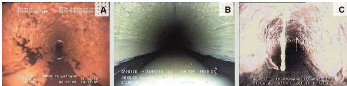
Abbildung 2.6: Darstellung von Sielhautablagerungen: A - Sielhaut, B - Sielhaut vorwiegend aus Fett, C - Sielhaut mit Fasern und Fett (aus Harting, K. 2006).
