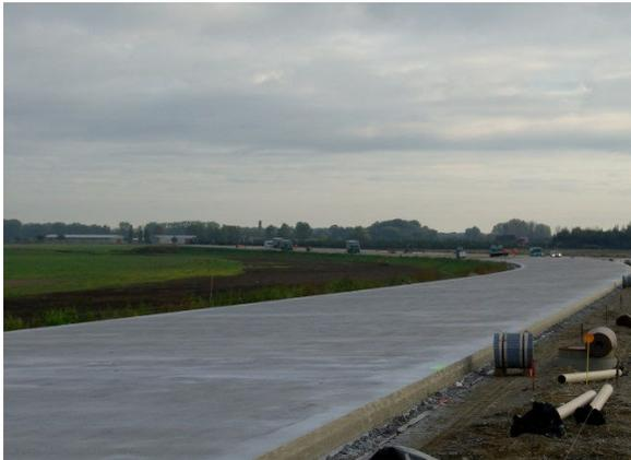
Bild 5.5: Erprobungsstrecke CEM III/A (1) B6n, Nähe Güsten (RIFA Quedlinburg), Oktober 2007.
