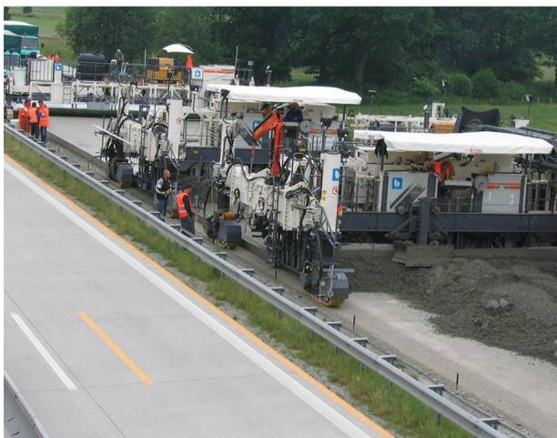
Bild 2.18: Gleitschalungsfertiger zur Herstellung einer Betonfahrbahndecke.
