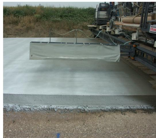
Bild 2.19: Auftrag des NBM von einer Nachläuferbühne.
