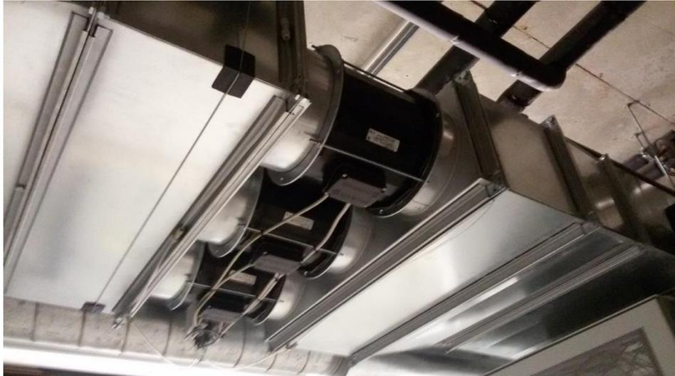
Abbildung 3.20: Ventilatorbox mit drei parallelgeschalteten Axialventilatoren
