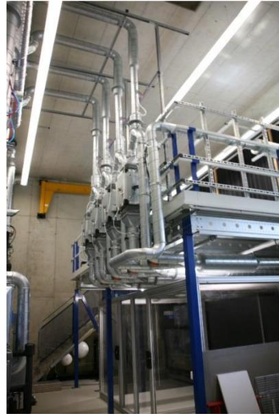
Abbildung 3.13: Bilder des RLT-Versuchsstandes links das modulare Zentralgerät und rechts die Verteilung der Luft
