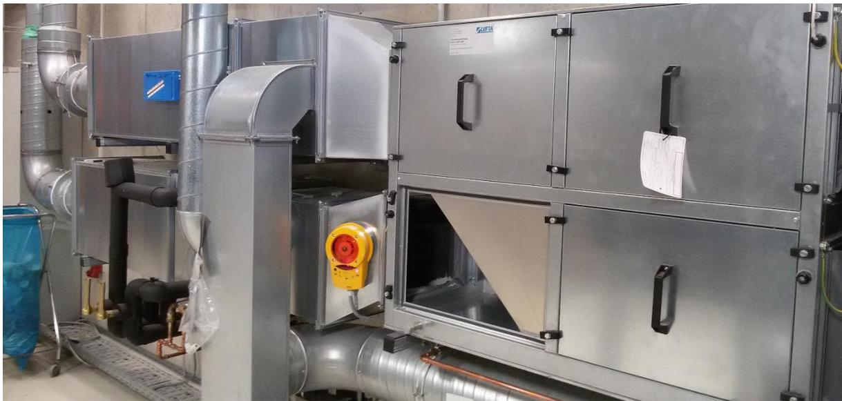
Abbildung 6.9: Gegen Umgebung geöffnete WRG des RLT-Versuchstandes
