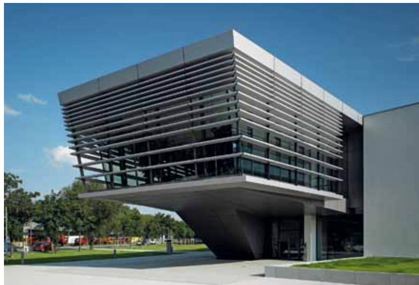
Besonders auffällig: die schräg gestellte Glasfassade des Foyers der Service-Akademie.
