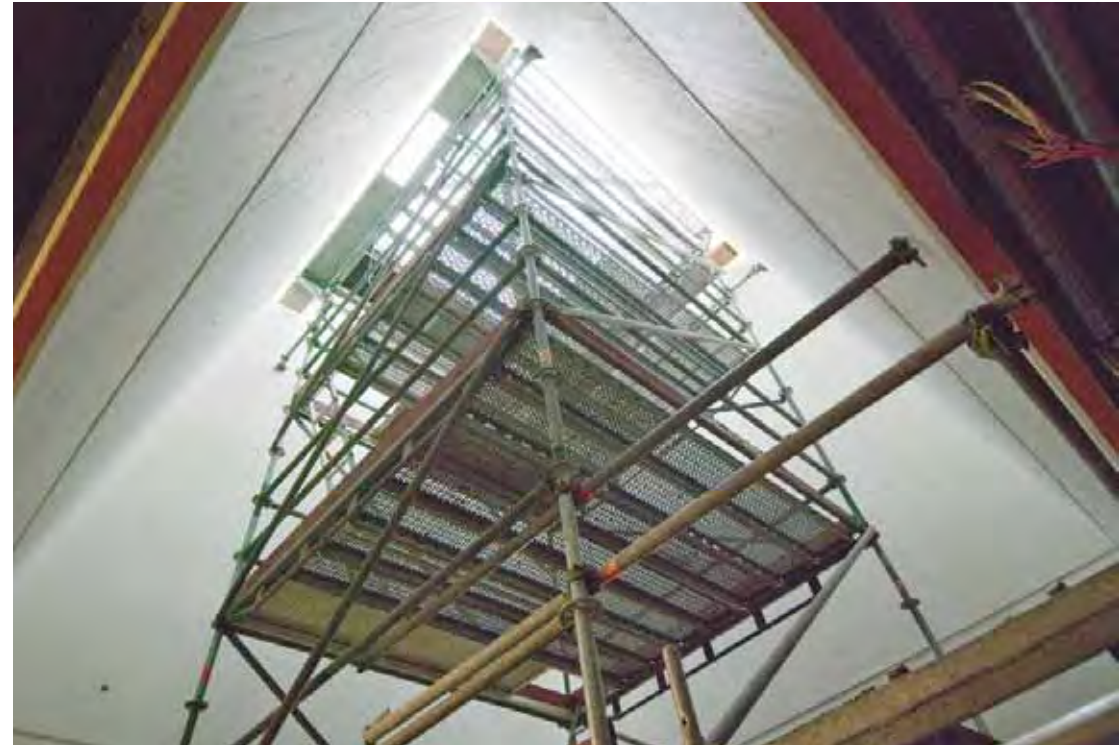
Baustelle Eingang Universität Süd
