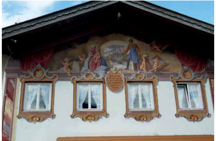
Große Dachüberstände bieten traditionell Schutz vor Regen für das Gebäude
