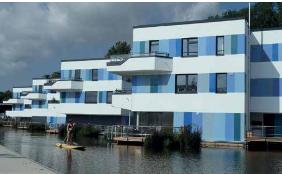
Dieses Wasserbassin bietet nicht nur sommerliche Abkühlung, sondern dient auch zur Abpufferung übermäßigen Regenanfalls (Regenrückhaltebecken) und damit Schutz vor Überflutung
