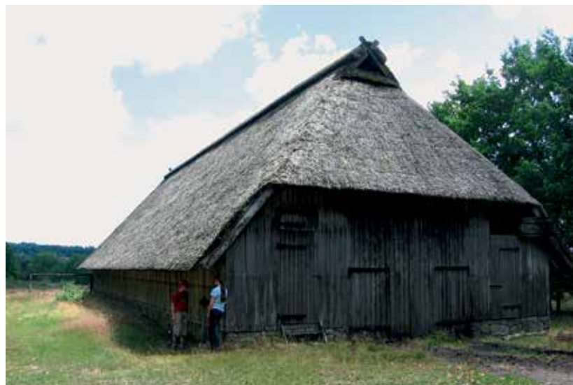
Durch das allseitig tief gezogene Dach bietet diese Scheune in der Lüneburger Heide einen guten Schutz vor „Wind und Wetter“
