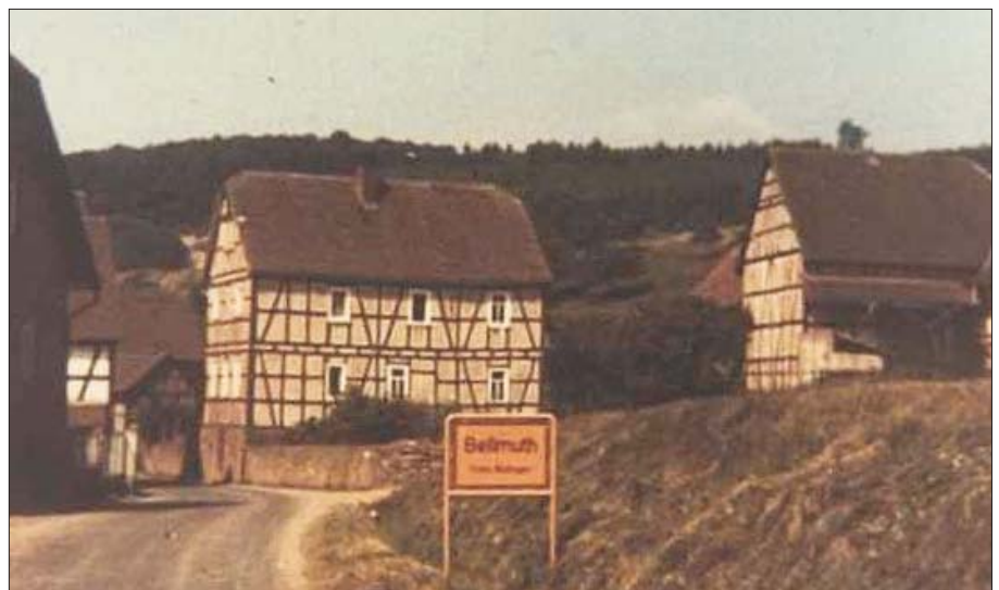
Abb. 1: Ortsschild “Bellmuth Kreis Büdingen” an der Kreisstraße K 198 (aus Richtung Bobenhausen). In der Bildmitte ist das Paulus’sche Haus ( ↔GPS1001 ) zu sehen, rechts die Scheune von “Kallefritzes” Hofreite ( ↔GPS1002 ). (Foto: W. Thum 1962)
