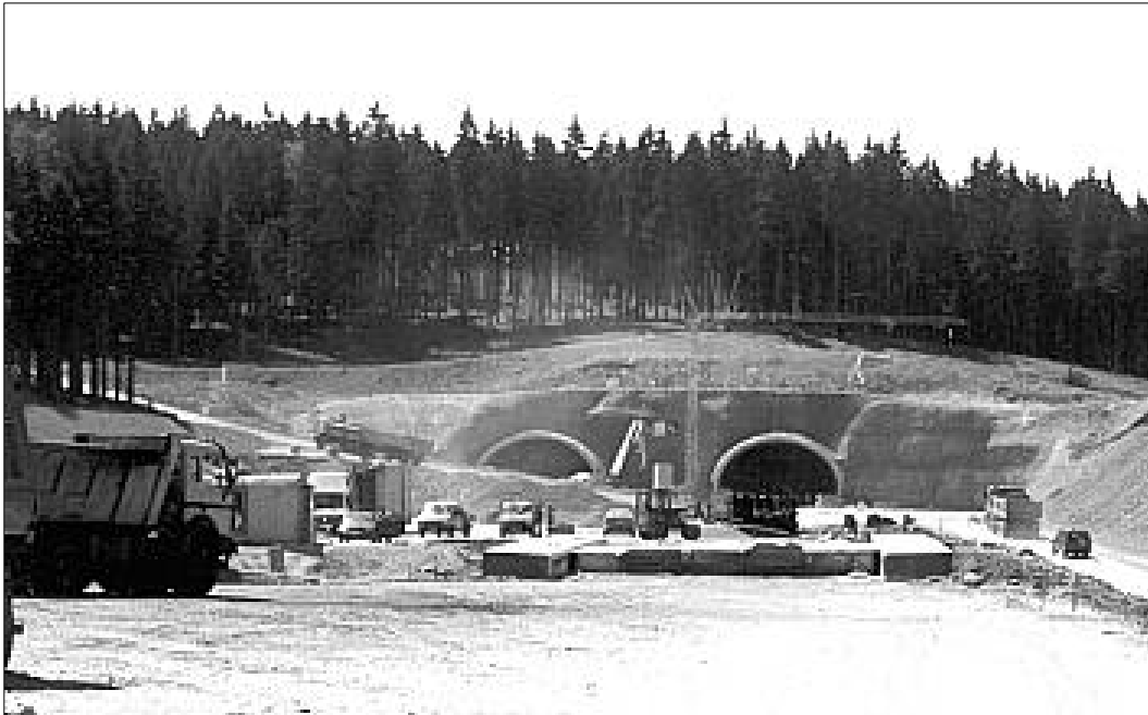
Bild 1 Südportal des Rennsteigtunnels
