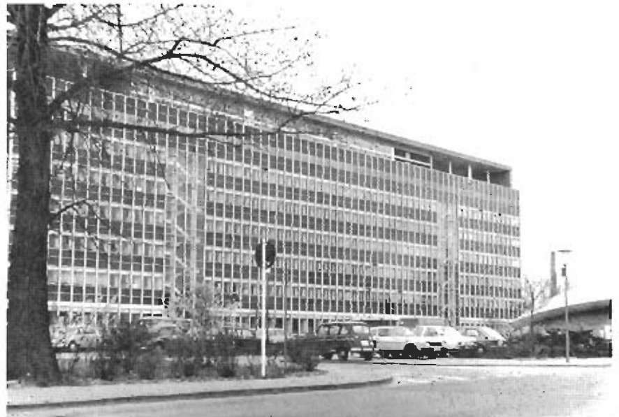
Das Institut für Meteorologie befindet sich in den obersten Stockwerken des Naturwissenschaftlichen Neubaus
