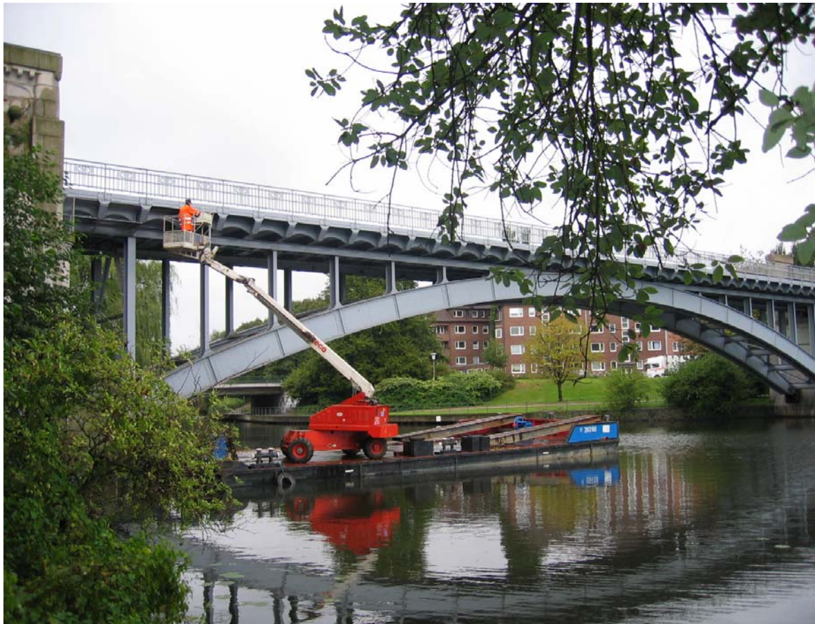
Abbildung 5: Brückenprüfung mit Steiger auf einem Hamburger Fleet.
