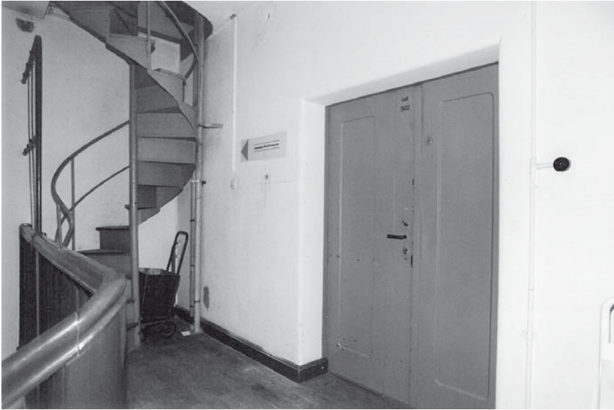
Bild 24: Wendeltreppe mit Zugang zum Sperrmagazin («Sondermagazin»), 1997
