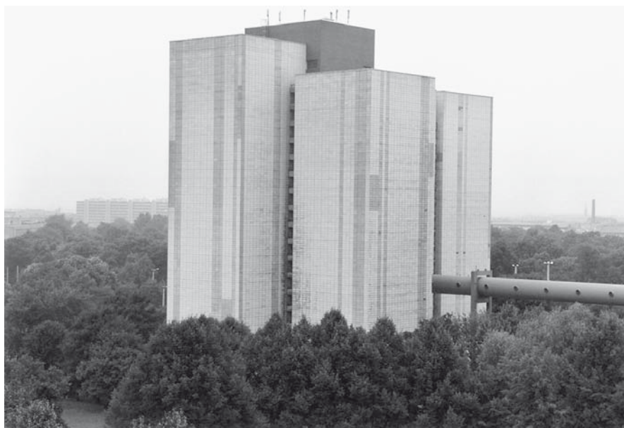
Bild 22: Der dritte Erweiterungsbau der Deutschen Bücherei (»Büchertürme«), 2001
