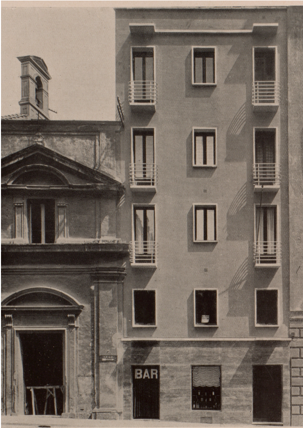
Abb. 2: Adalberto Libera: Casa Pigione, Rom; Fassadenumbau eines Altstadthauses [Architettura 1933, p. 638].
